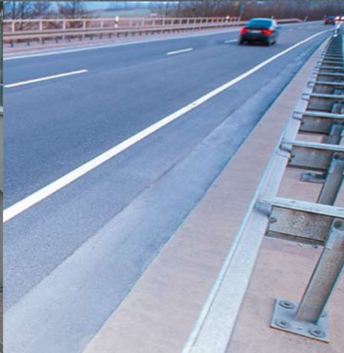
Gussasphaltrinne, Brücke Satteldorf
